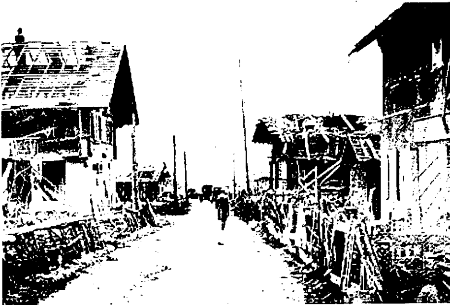
Durch Trümmerwurf zerstörte Häuser an der Hauptstrasse in Mitholz
