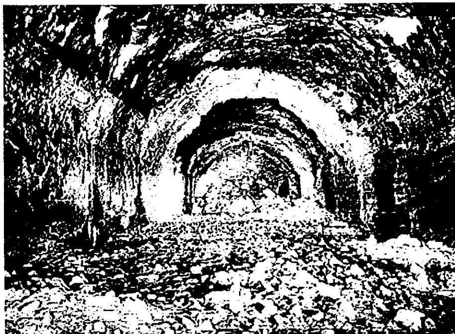
Der Ausgangsort des Unglücks konnte nur im Bereich der Kammern 1, 2 und 3 lokalisiert werden. Hier war 7,5 cm Artilleriemunition gelagert. Das Bild zeigt den Blick gegen den verschütteten Eingang der Kammer 1. Der Kammereinbau wurde vollständig zerstört.
