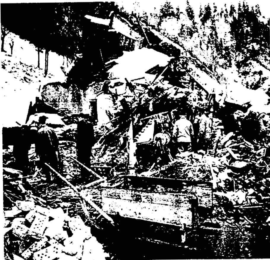
Die Aufrämequipen beim zerstörten Bahnhofgebäude von Blausee - Mitholz. Das Gebäude wurde während der zweiten Explosion durch den Gasdruck und die ausgeblasenen Felstrümmer und brennende Geschossteile zerstört. Der Bahnhofsvorstand und seine Frau wurden im Schlafe überrascht und fanden den Tod.
