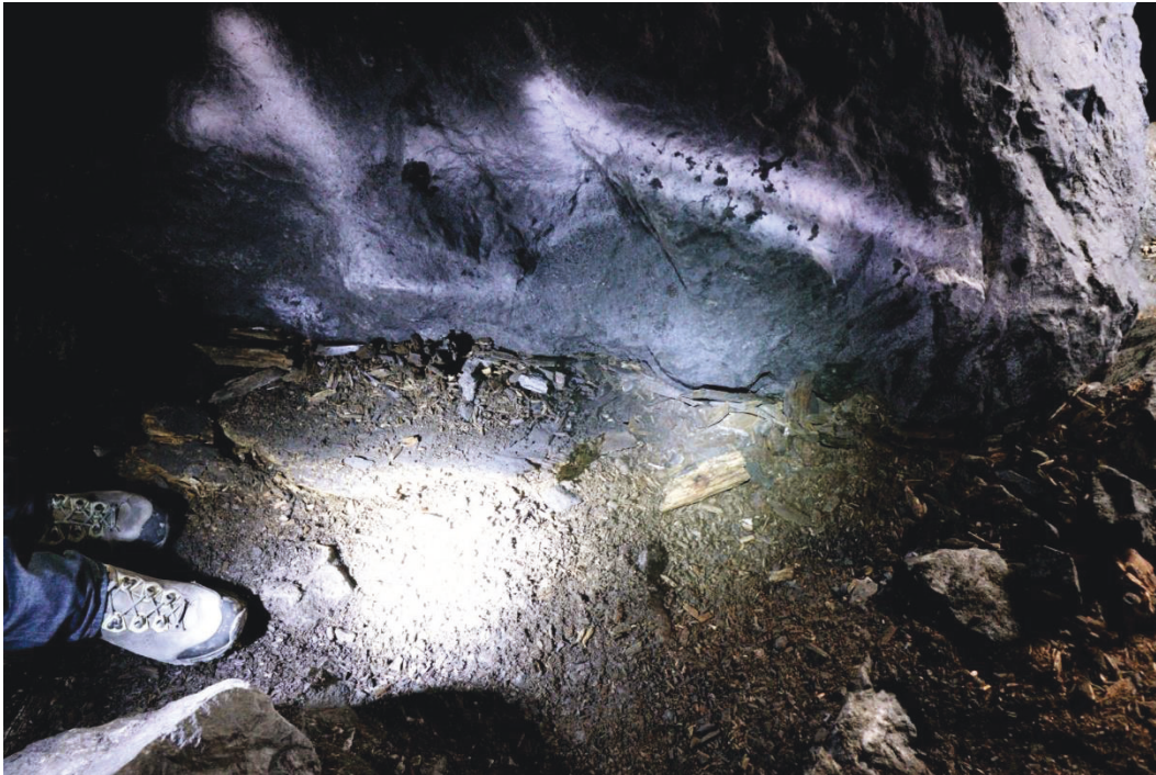
Bild A1-7: Holzreste im Bahntunnel zwischen den Kammern 10 und 12
