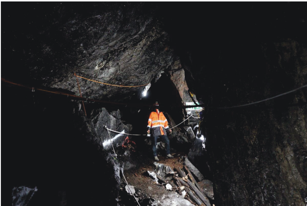
Bild A1-12: Ablösungen vom First des Bahntunnels zwischen den Kammern 10 und 12
