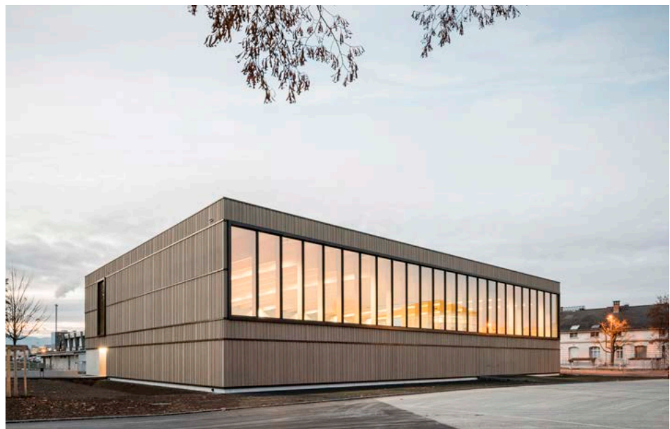
Abbildung 10: Mehrzweckhalle Waffenplatz Thun
