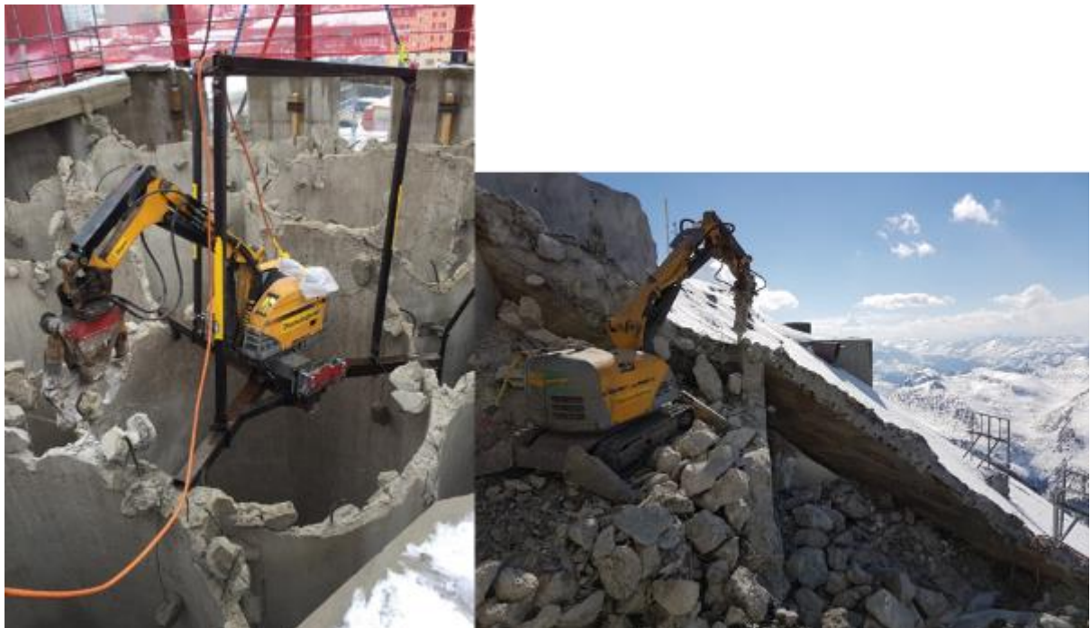
Abbildung 16: ferngesteuerte Baumaschinen (aus Präsentation "Projektteam-Sitzung XIII vom 27.01.2020")
