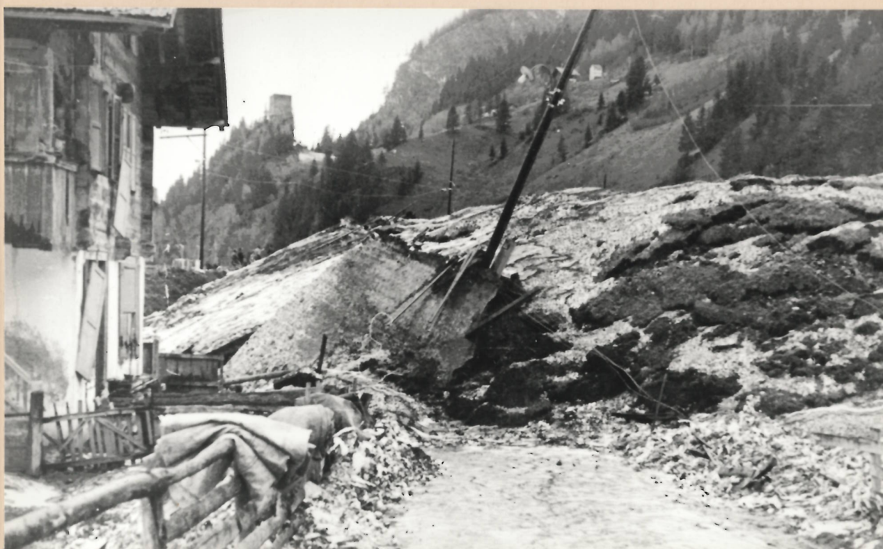
Durch Bodenverdrängung gehobene Kantonsstrasse
