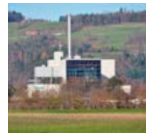
Usine d'incinération de déchets de Thoune (photo: Matzke)
