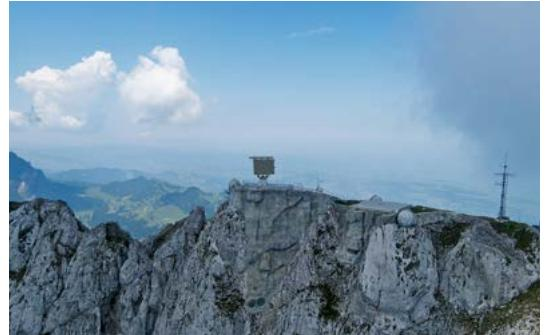
La Rete di condotta Svizzera (in precedenza denominata Rete d'impiego Difesa) è una rete fissa basata su cavi in fibra ottica e ponti radio che garantisce la sicurezza delle comunicazioni. Essa funziona anche quando i mezzi civili sono fuori uso. La Rete di condotta Svizzera sostituisce le precedenti reti in fibra ottica e ponti radio con un'unica rete di trasmissione a banda larga conforme allo stato della tecnica. Alla fine del corrente decennio dovrebbe essere quasi interamente in funzione.
